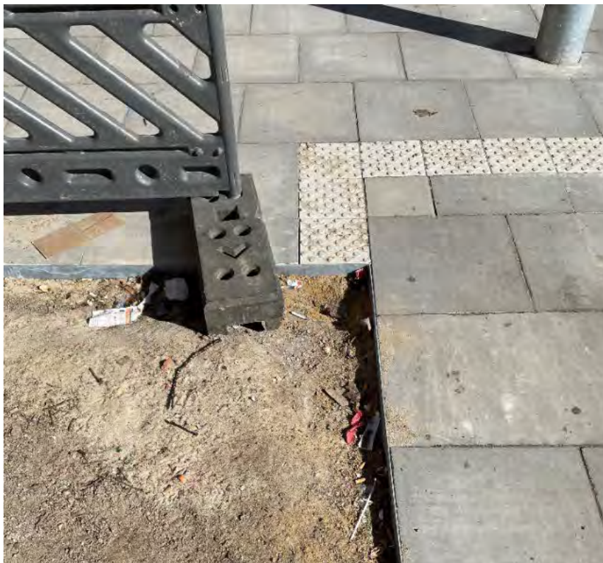
Abbildung 11: Beispiel eines Stahlbandes in Hamburg | Quelle: IPP
