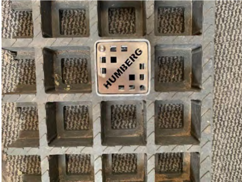
Abbildung 10: Beispiel eines Lüftersteins | Quelle: LSBG
